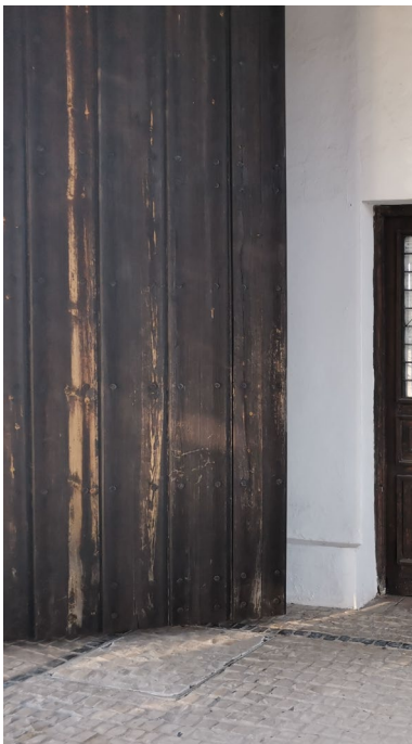
Puerta entrada principal
