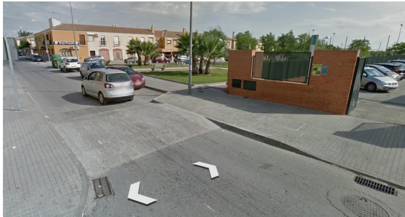
Paso peatonal existente en Avda. Blas Infante (frente a entrada instituto)
