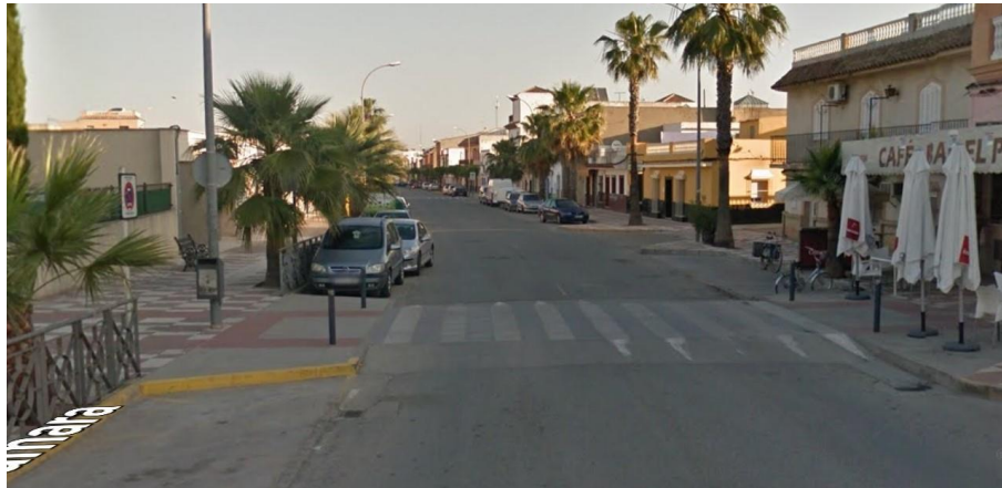
05. Paso peatonal existente frente al C.E.I.P. "El Pinar"
