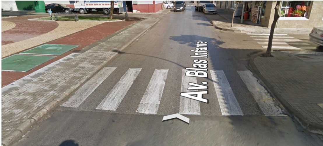
Paso peatonal existente en Avda. Blas Infante (frente a Parque "El Gamo")
